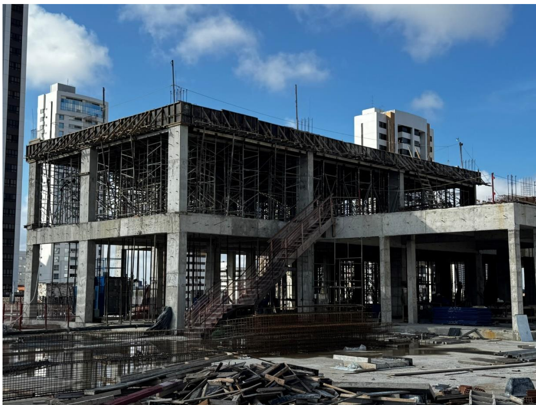
Figura 4. Concretagem da primeira etapa da laje de cobertura do primeiro pavimento.
