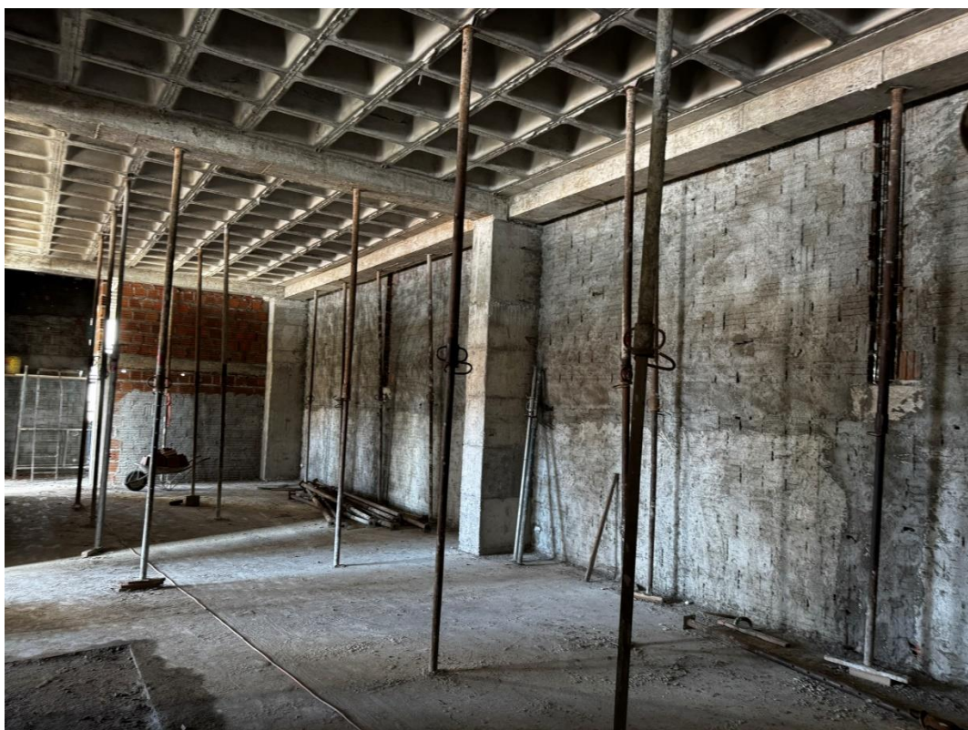
Figura 7. Elevação de alvenaria no segund semienterrado.
