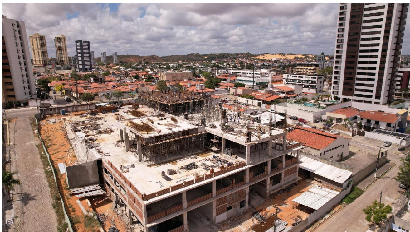
Figura 1. Visão geral da obra.
