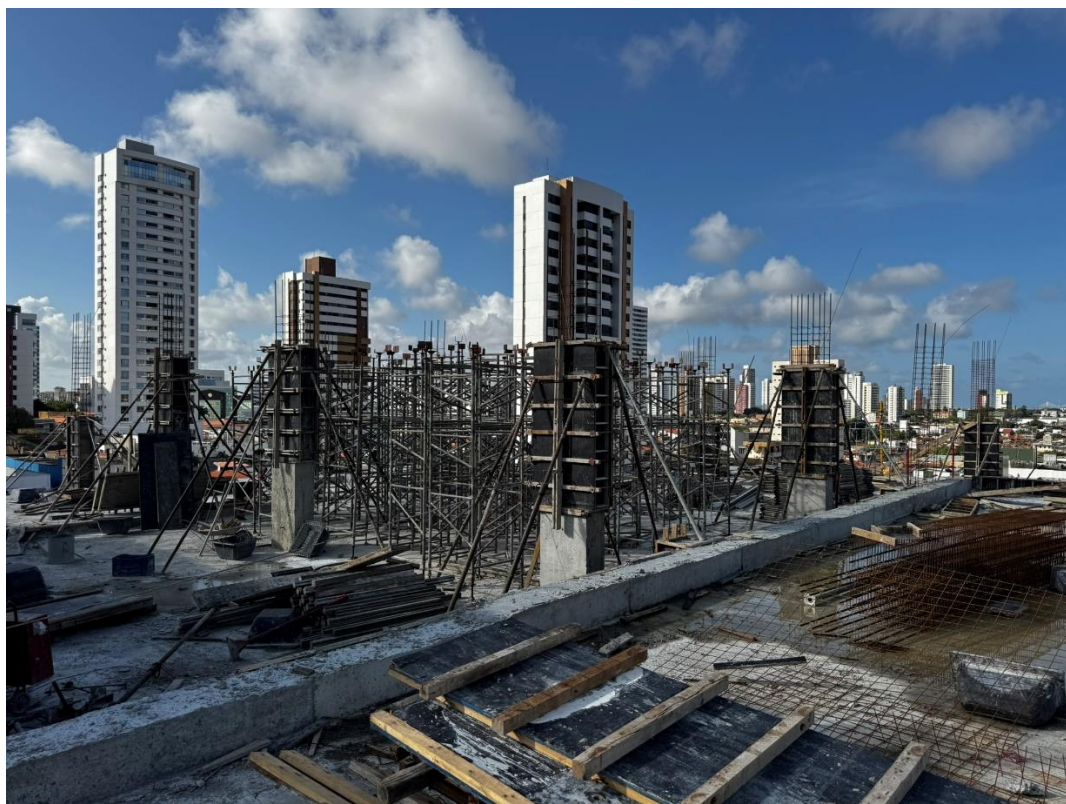
Figura 5. Montagem e concretagem da segunda etapa dos pilares do primeiro pavimento.
