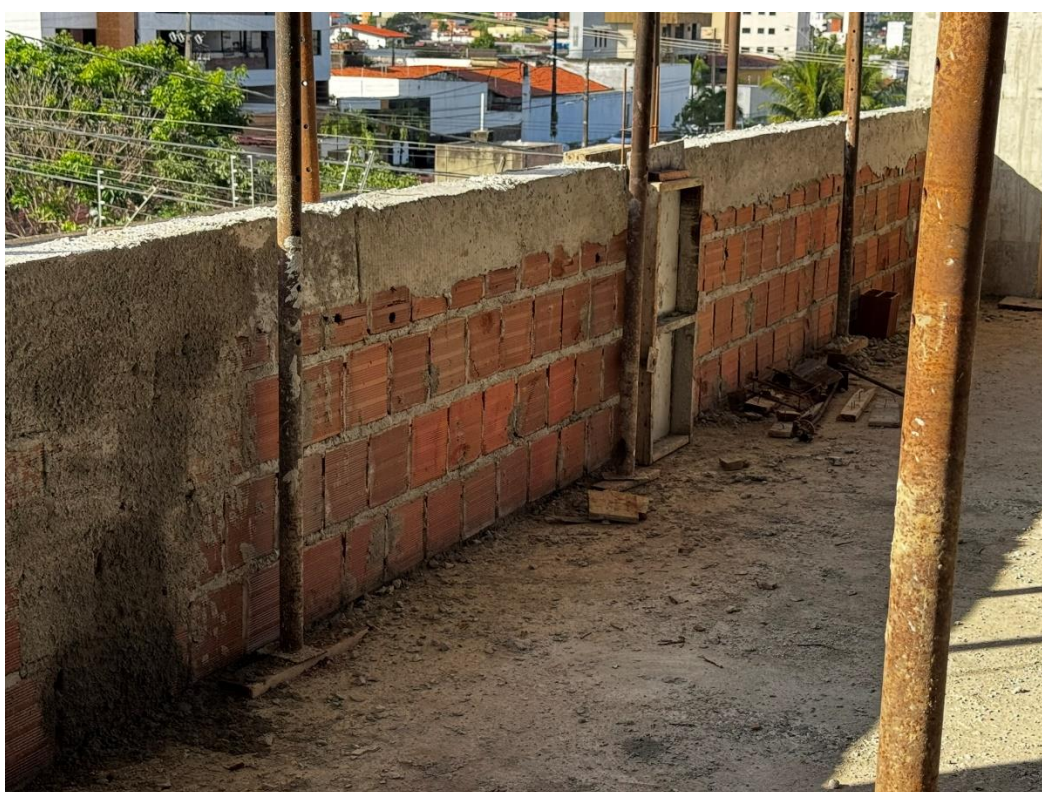
Figura 8. Elevação de alvenaria no primeiro semienterrado.
