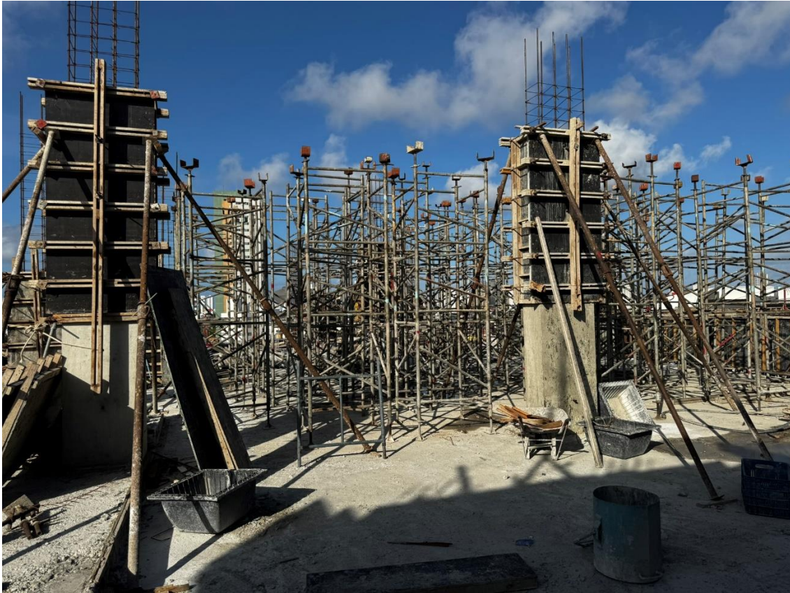
Figura 6. Montagem do sistema de escoramento para instalação da segunda parte da laje de ecobertura do primeiro.
